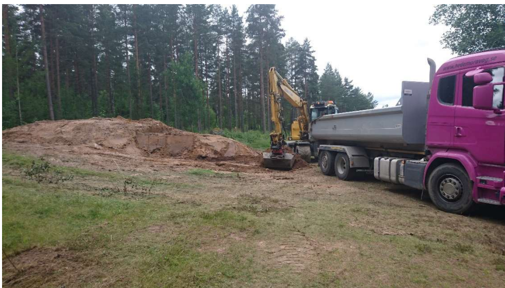
Bild 1. 30 juni 2021. Bortgrävning av blyförorenade massor i hög vid fd. jaktskyttebana, Mora By, Gustafs, Sätters kommun
