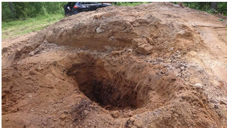
Bild 5. 30 juni. ProvGrop 1 (PG1) grävdes för att säkerställa att det inte fanns mer förorenade massor djupare ned. Dock är sannolikt saneringsbotten här endast några dm ovan ursprunglig marknivå.
